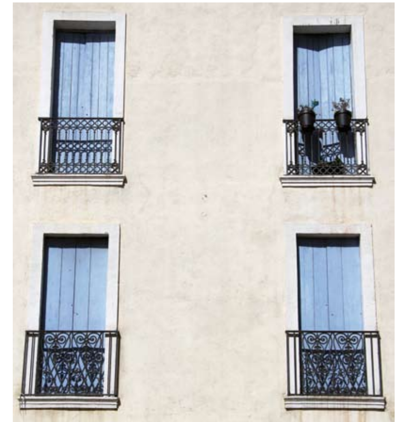
Balcons rue du square de la Fontaine
